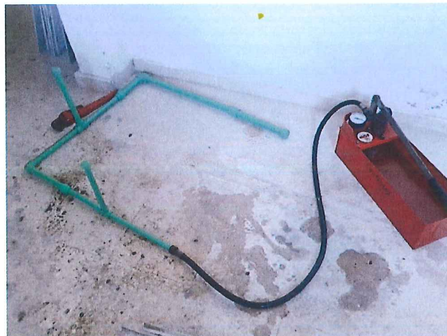
Figura 3. Prueba de estanqueidad del sistema.
